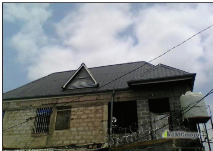
Le type de maison de l'ancien Camp Cito
